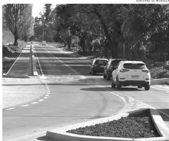
Ya está terminada la obra que trae una solución al tránsito.
