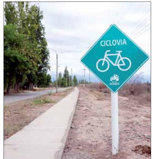
La obra es muy esperada por los vecinos.
