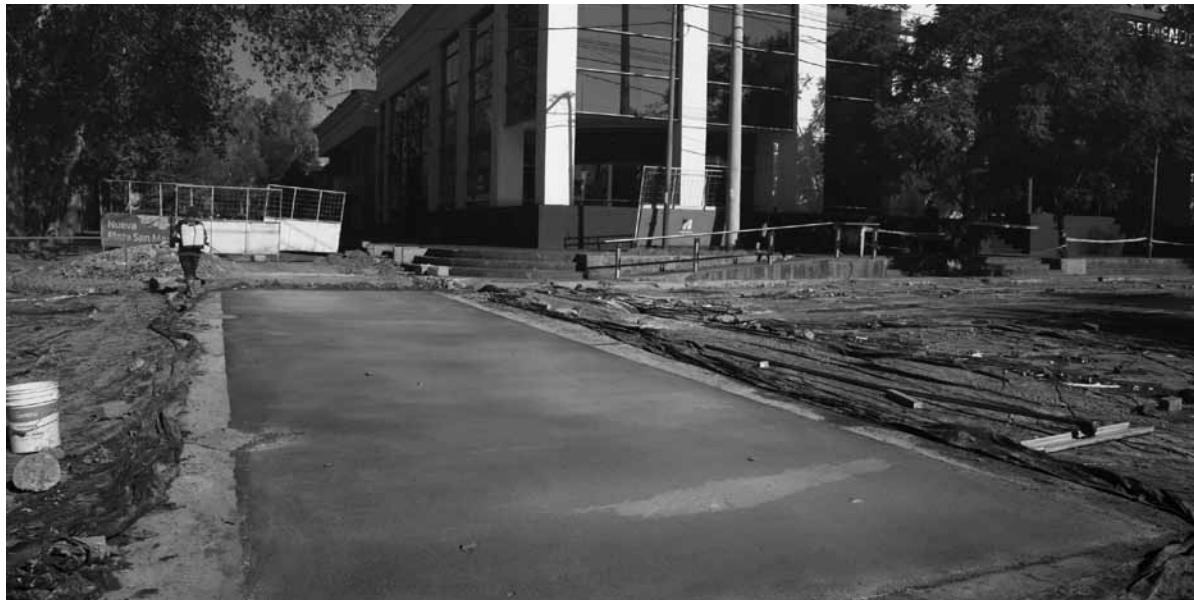
Trabajan en el hormigonado de las calles.
