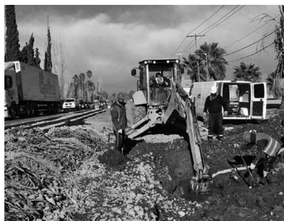
Es intenso el trabajo en la transitada calle.
